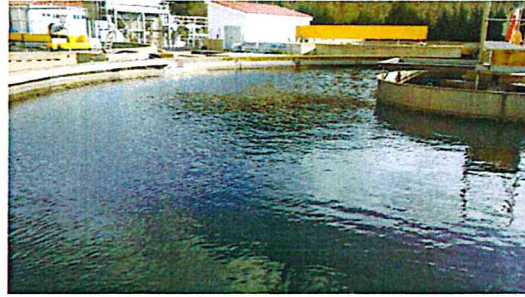
Fotografía 2.3. Limpieza del decantador
